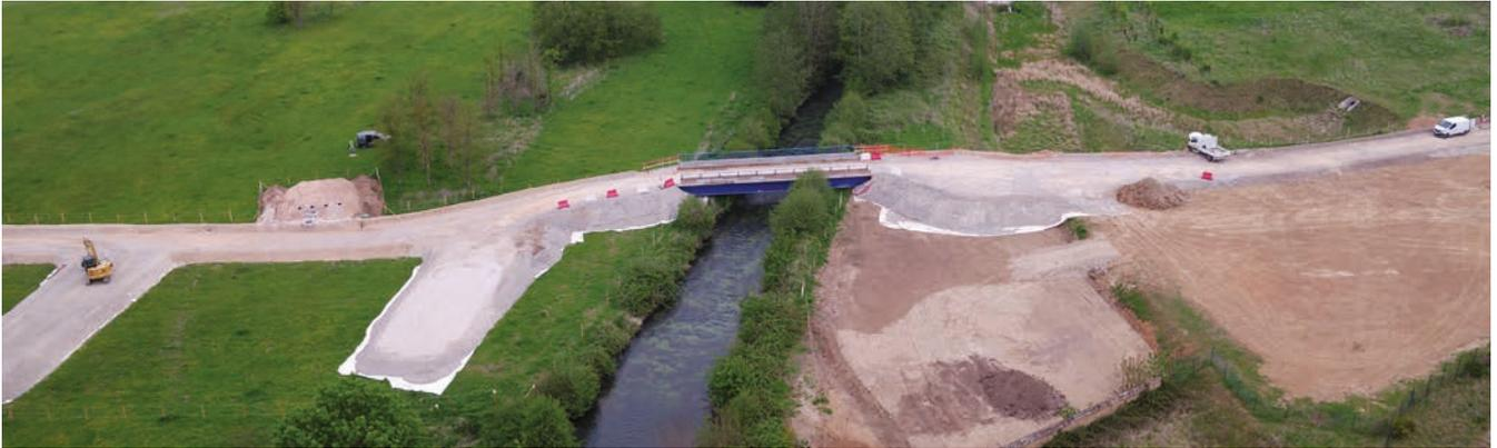
**Les travaux de fondations du futur viaduc ont démarré début mai et consistent en la réalisation des piles et des culées de l'ouvrage d'art.**
