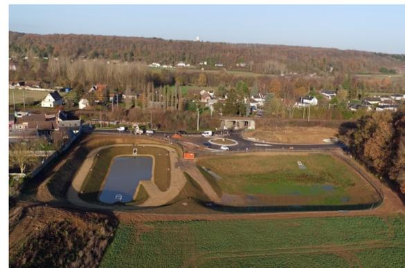
*Construction du Bassin 2Ter et sa noue d'infiltration*
